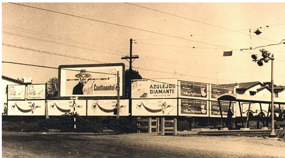
Foto 01: Diversos painéis, data provável déc. 1940, Av. Ascendino Reis, São Paulo/SP
